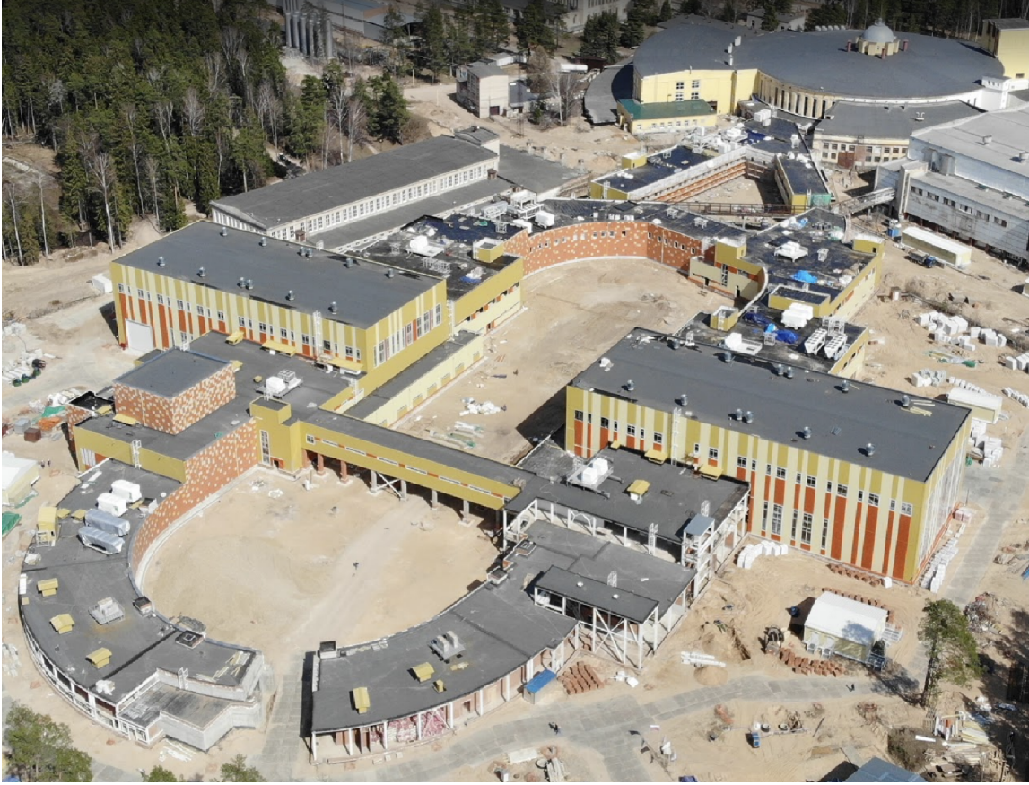
Рис. 18: Стройплощадка комплекса NICA.
